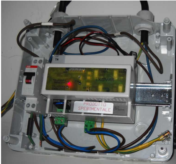
Esempio di installazione di Ekovar, in centralino modulare, su barra di supporto DIN.
